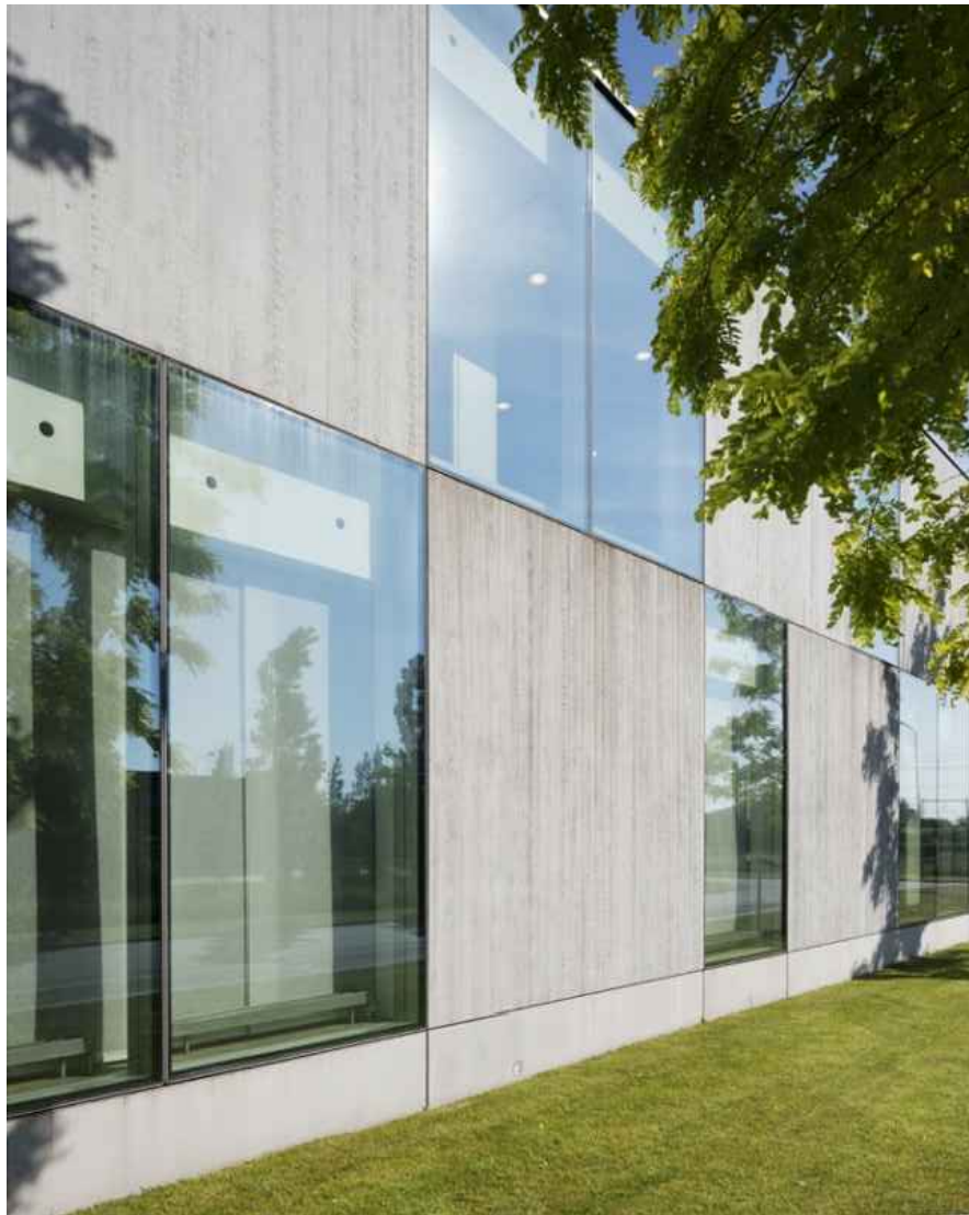
Beton (Schoonwerk) samengesteld met structurele beglazing
