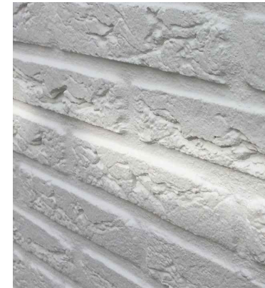
Gekeimd metselwerk, lichte kleur
